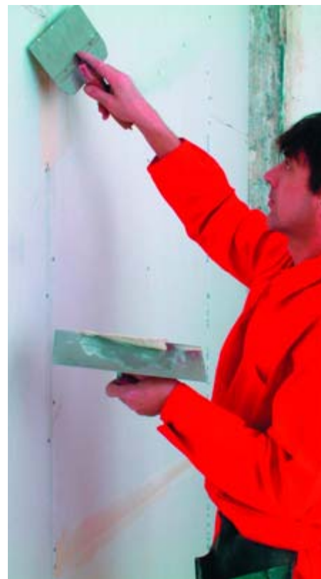
Tmelení bandážovaných spár desek mezi sebou
