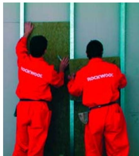
Vkládání kamenné vlny - desky jsou kladeny bez mezer, každá další deska se musí shora natlačit na předchozí
