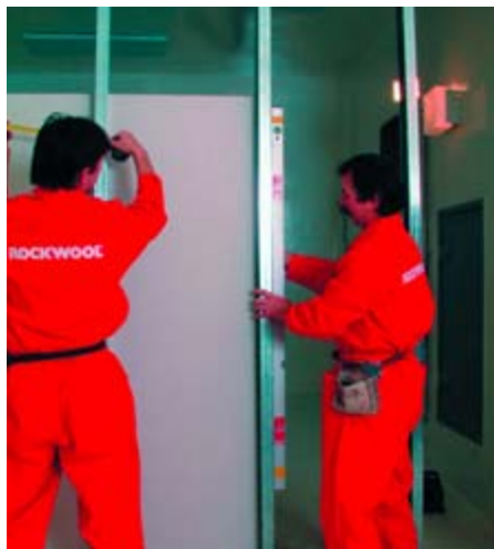
Rozměření a přesné sestavení roštu
