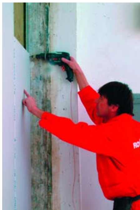
Zaklápění a kotvení SDK desek šroubováním
