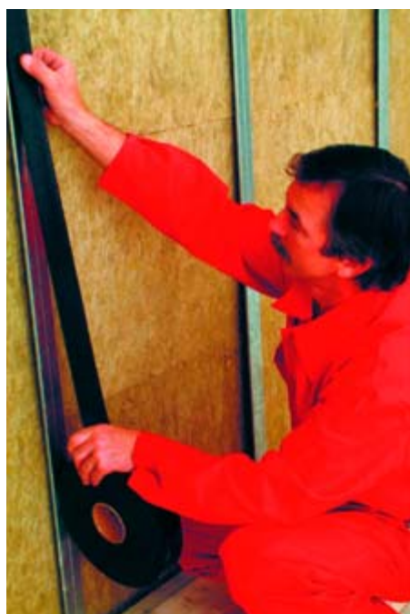
Zlepšení charakteristiky příčky - jednostranný polep roštu PE páskou
