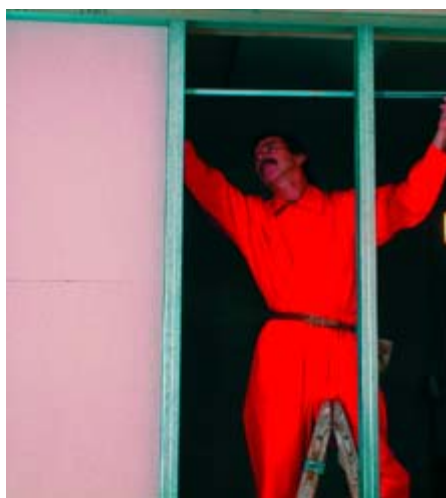
Naměřené a přiřazené desky SDK - spoje desek na obou pláštích budou vystřídaně proti sobě
